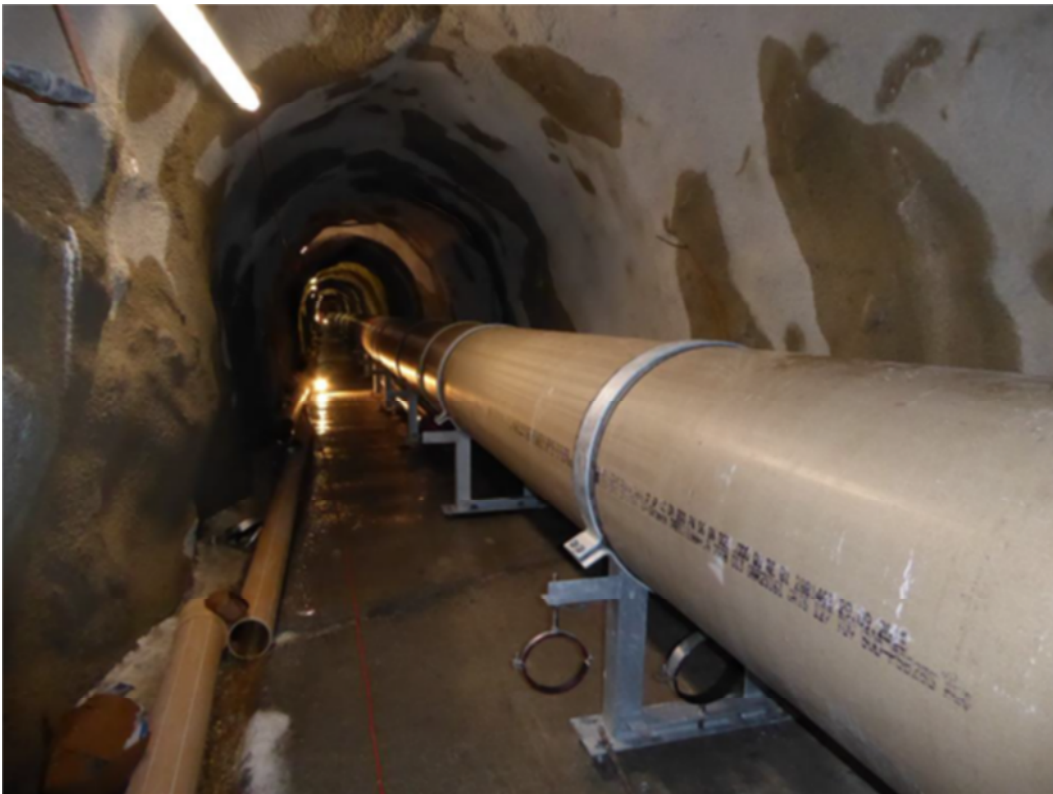
Beispiel des zukünftigen Stollens mit Druckleitung
